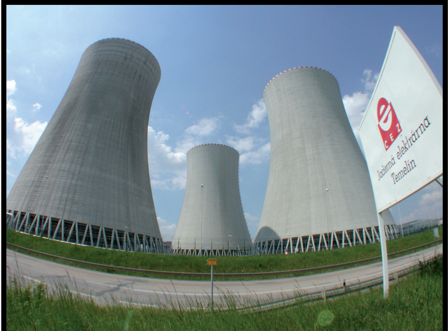
AKW Temelin: 14 INES-1-Störfälle wurden nicht korrekt an Österreich gemeldet.
